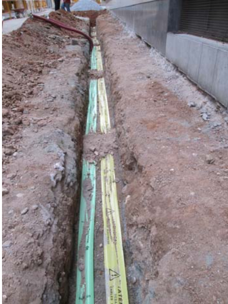
FOTO 1. Vista general de la Rasa 1 com cop finalitzada
