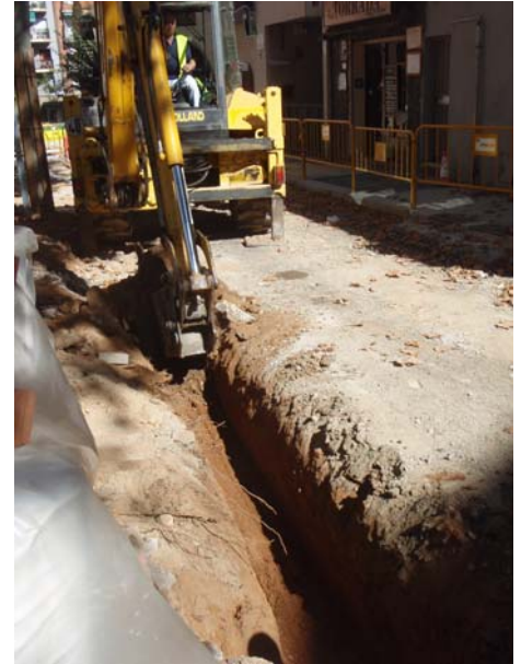
FOTO 14. Treballs mecànics d'obertura de la rasa 4
