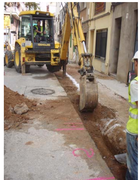
FOTO 8. Treballs d'obertura de la rasa 3
