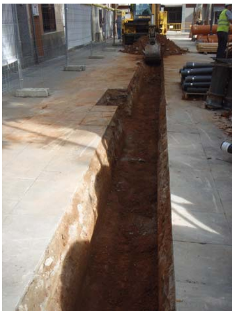
FOTO 11. Vista general de la rasa 5
