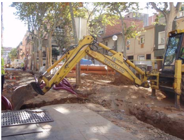
FOTO 15. Realització de la rasa 6
