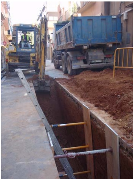
FOTO 19. Treballs d'obertura de la rasa 8
