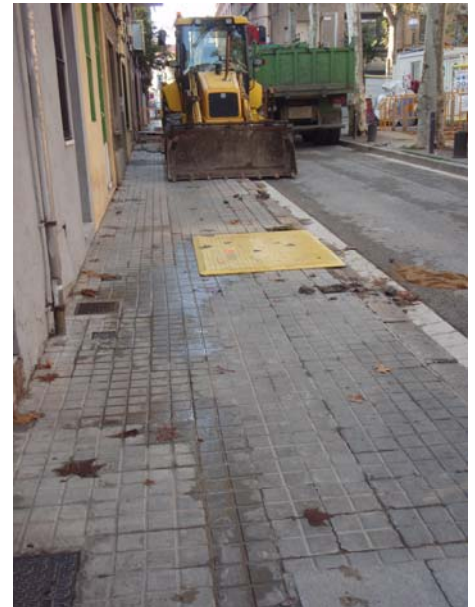
FOTO 6. Vista general abans d'iniciar els treballs d'obertura de la rasa 3
