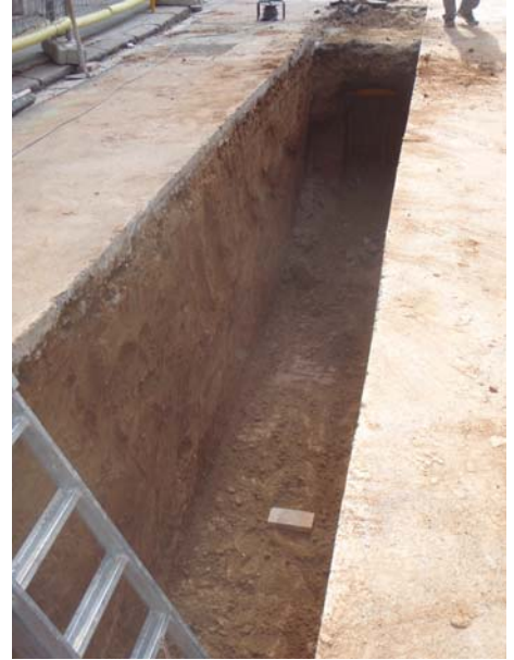
FOTO 18. Vista general de la rasa 8
