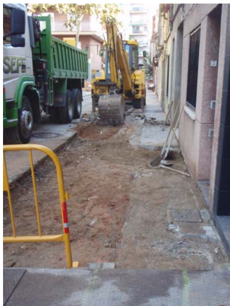
FOTO 7. Retirada dels panots UE 07 (rasa 3)
