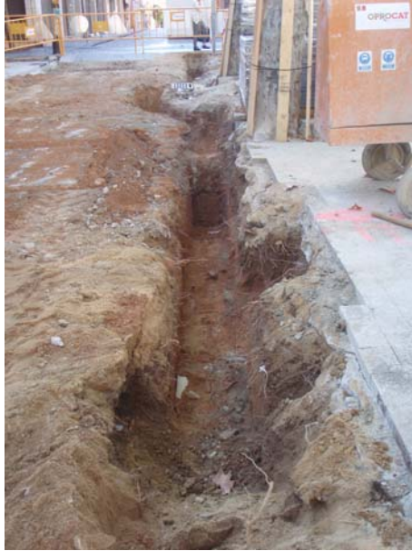
FOTO 13. Vista general de la rasa 4
