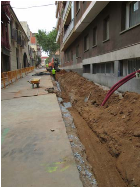
FOTO 3. Treballs d'obertura de la Rasa 2
