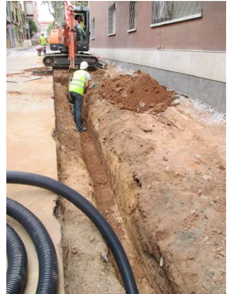
FOTO 2. Obertura de la Rasa 2
